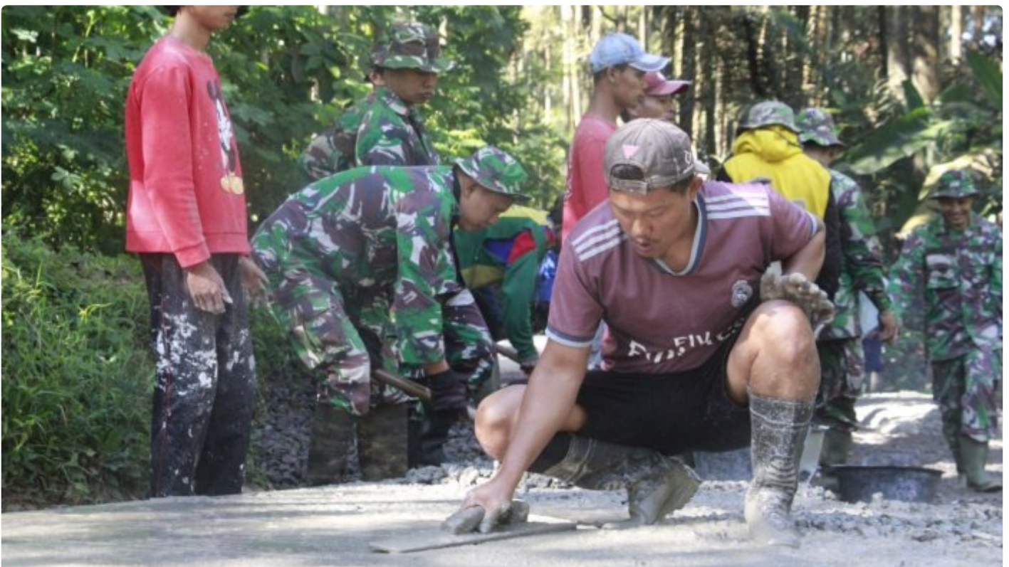
Anggota Satgas TMMD Kodim 0706 Temanggung Bersama Warga di Lokasi Proyek Pengecoran Jalan
