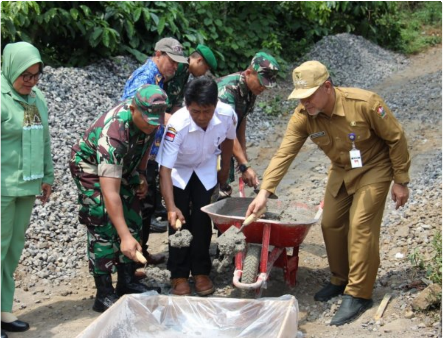
Simbolis Pengecoran Pertama Betonisasi
