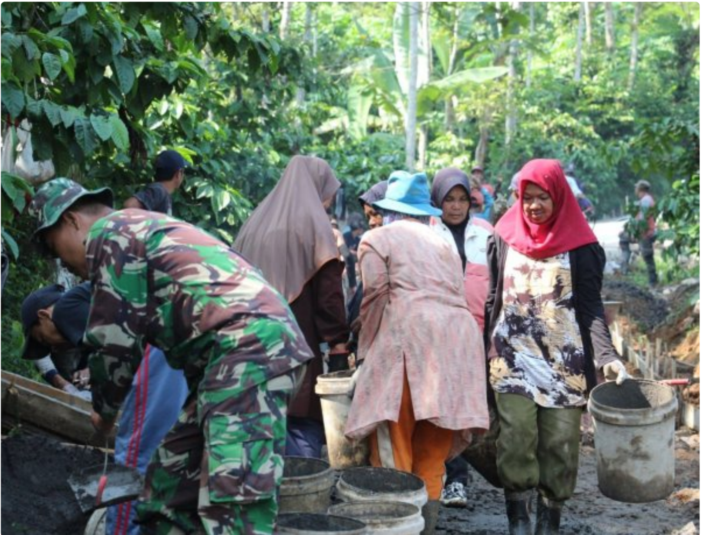
Ibu Ibu Bantu Percepat Pembangunan TMMD
