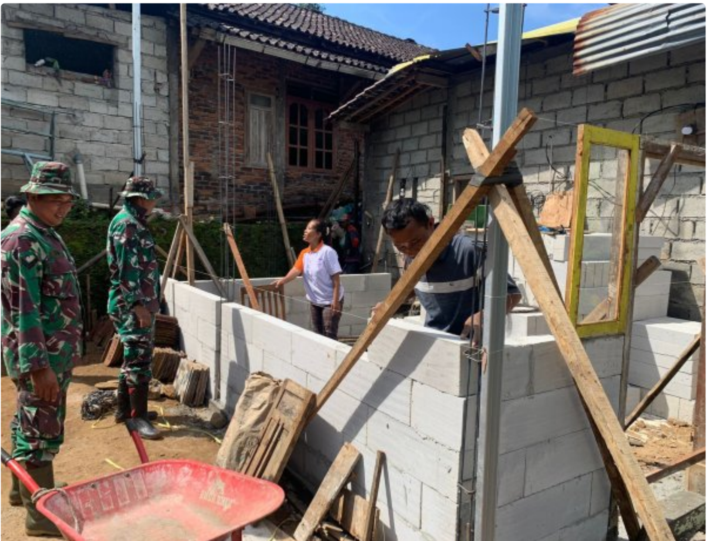
Pemasangan Dinding Menggunakan Herbel
