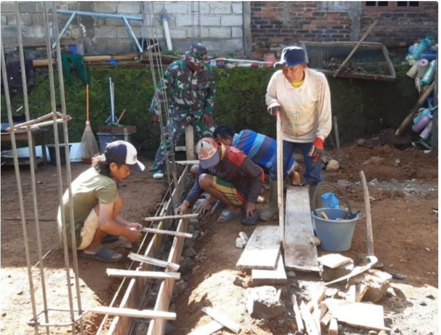
Pemasangan Bekisting Balok Sloof
