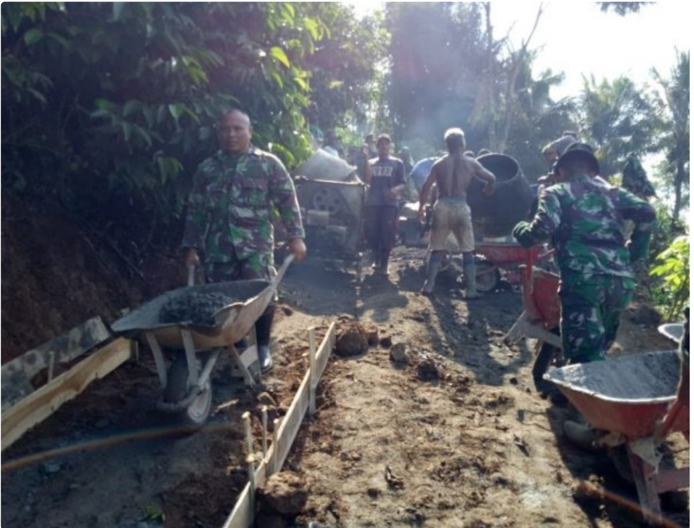
Satgas TMMD Kebut Pengecoran Jalan
