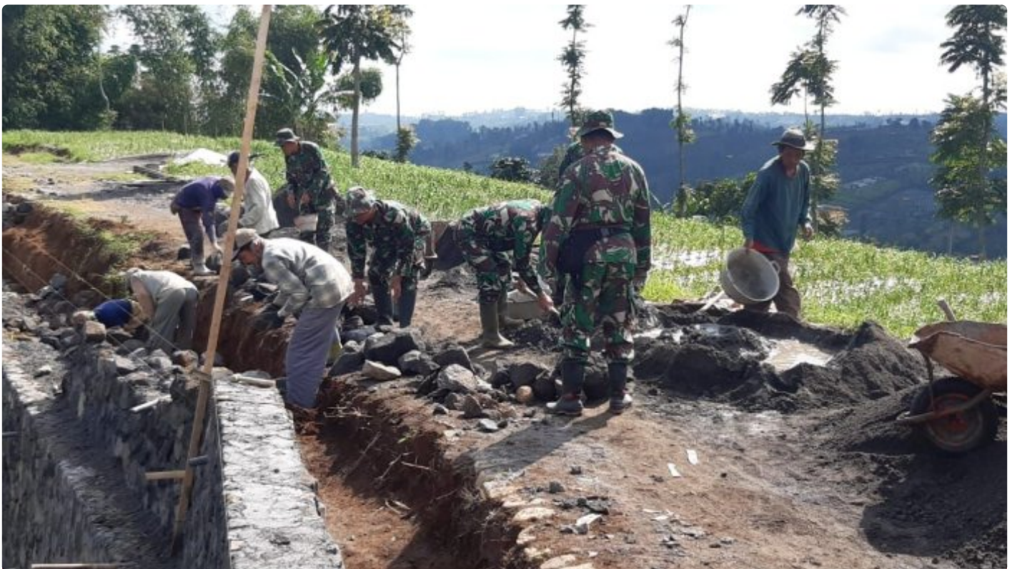
Satgas TMMD dan Warga Bahu Membahu Kebut Pengecoran Jalan
